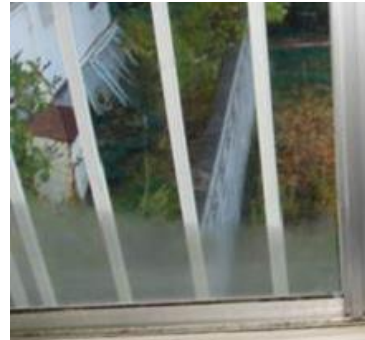
<施工後> 朝方 結露の改善
